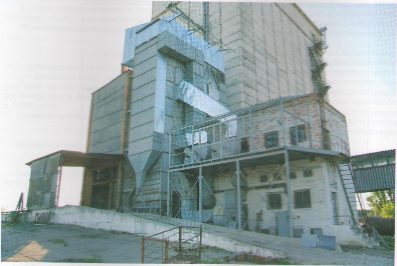
Рис. 2. Зерносушарка в процесі реконструкції
