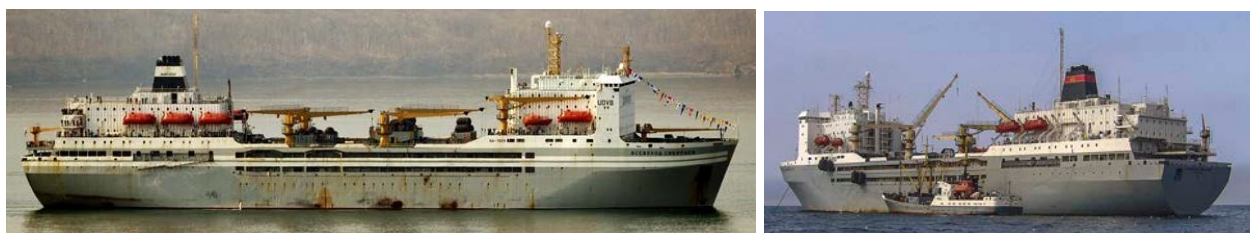
Рис. 10. Коррозионные повреждения обшивки корпуса т/х «Всеволод Сибирцев», вызванные локальным разрушением ЛКП [фото: Сергея Скрыбина https://MarineTraffic.com ]
