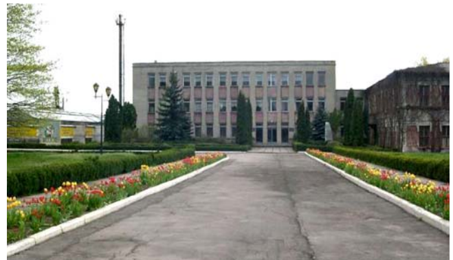
Рис. 1. Адмінбудинок Уманської дослідно-селекційної станції / Administration building of Uman Research and Breeding Station
