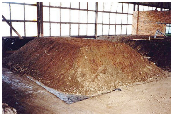
Fot. 1. Widok przyzmy technologicznej utworzonej z gleby oczyszczanej metodą ex situ na wydzielonym stanowisku oczyszczania [P. Kaszycki]
